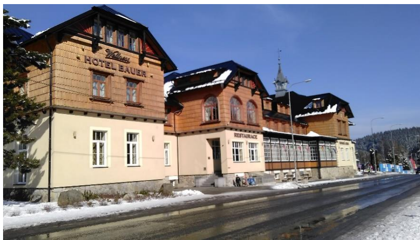
Obr. 7. Modernizovaný Wellness hotel Bauer, dřívější zařízení vázané rekreace (Foto J. Havrlant 2019)
